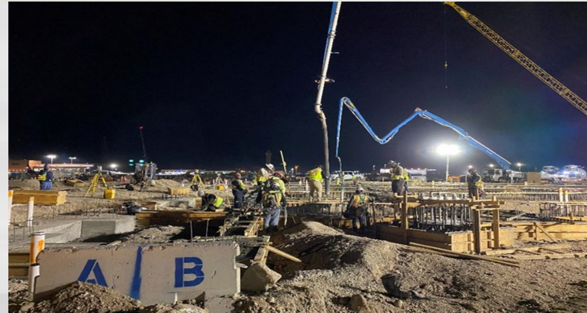
Grade Beam Concrete Pour
