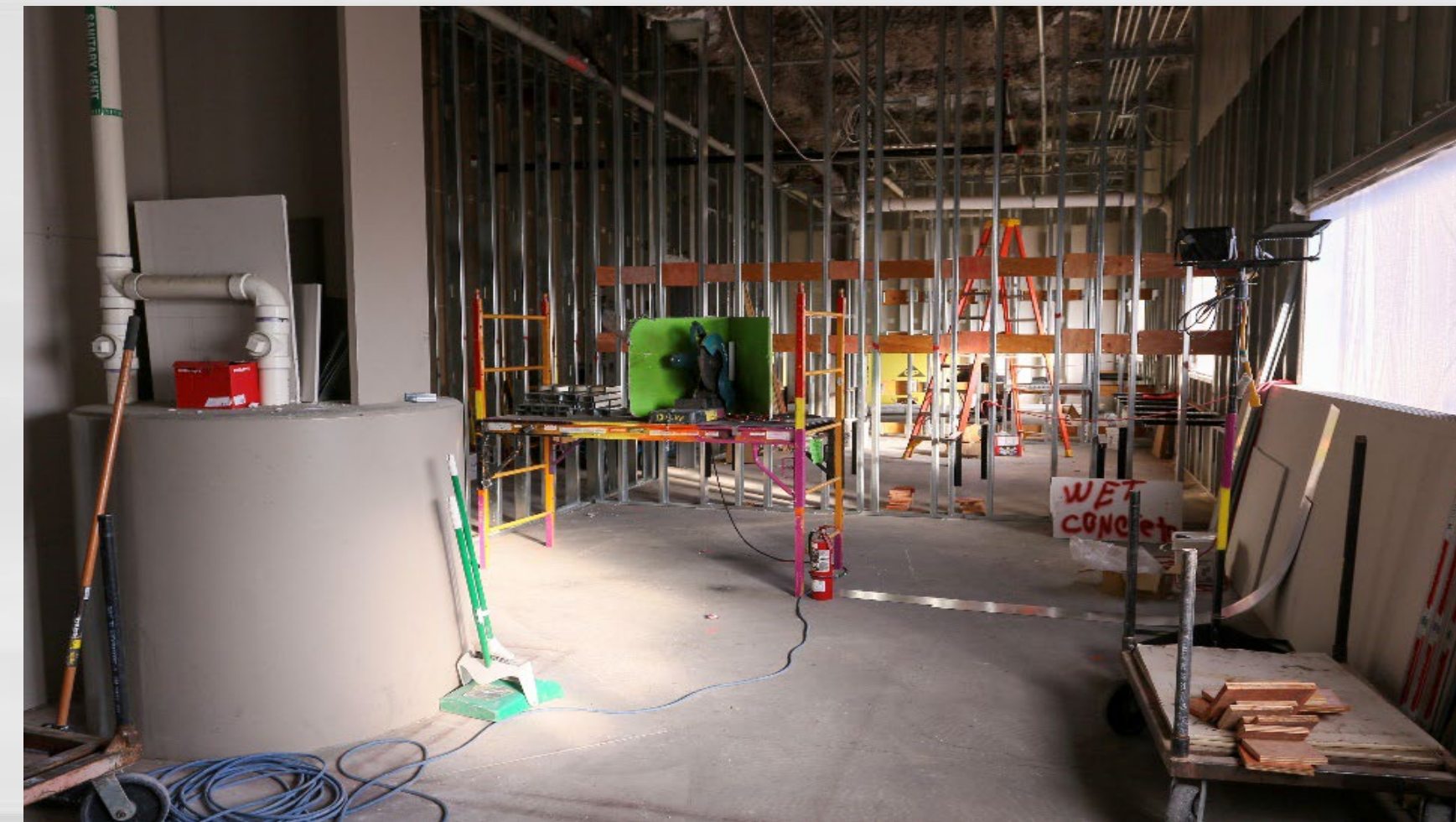
Interior Stud Framing
