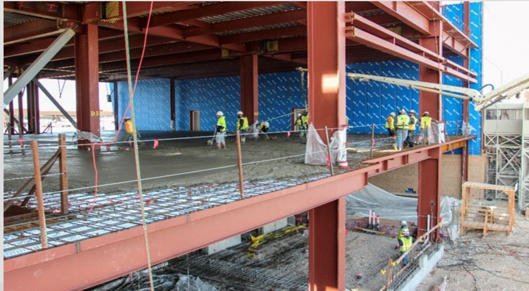
First Slab on Metal Deck Concrete Pour
